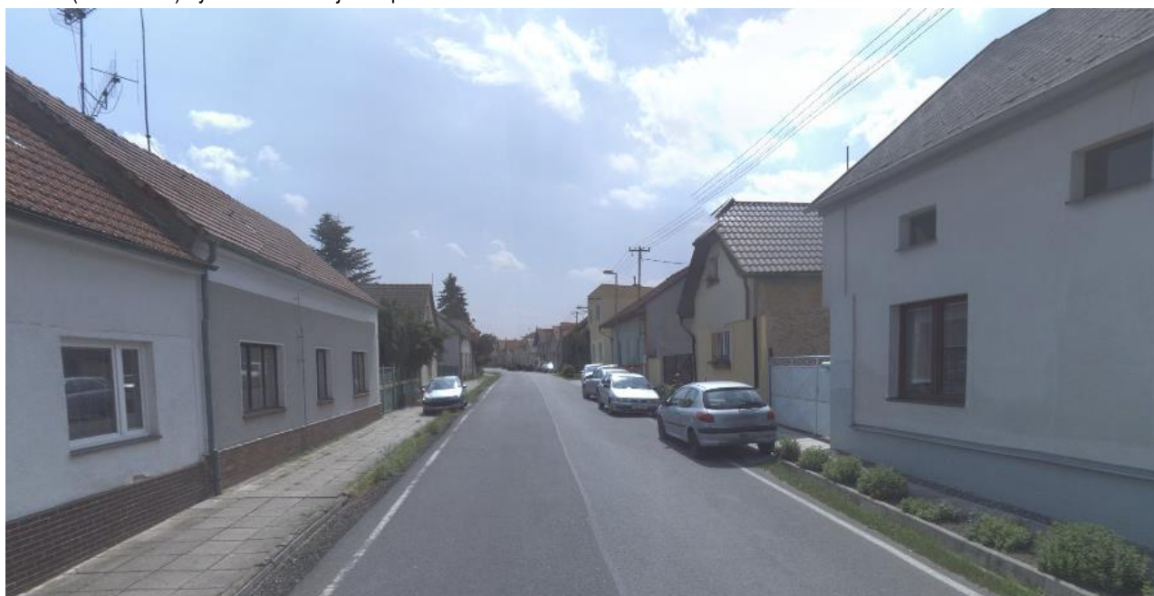
Chrast - stav (nevyhovující)
