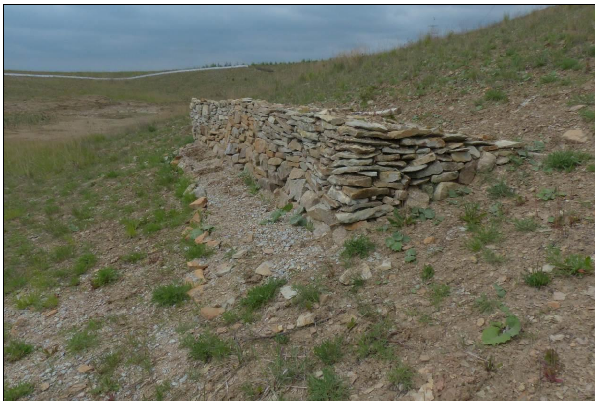
Foto 21-22. Vzor provedení suché zídky skládané kamenů (20 – zídka v blízkosti nově vyhloubené tůně; 21 – zídka zapuštěná do svahu).
